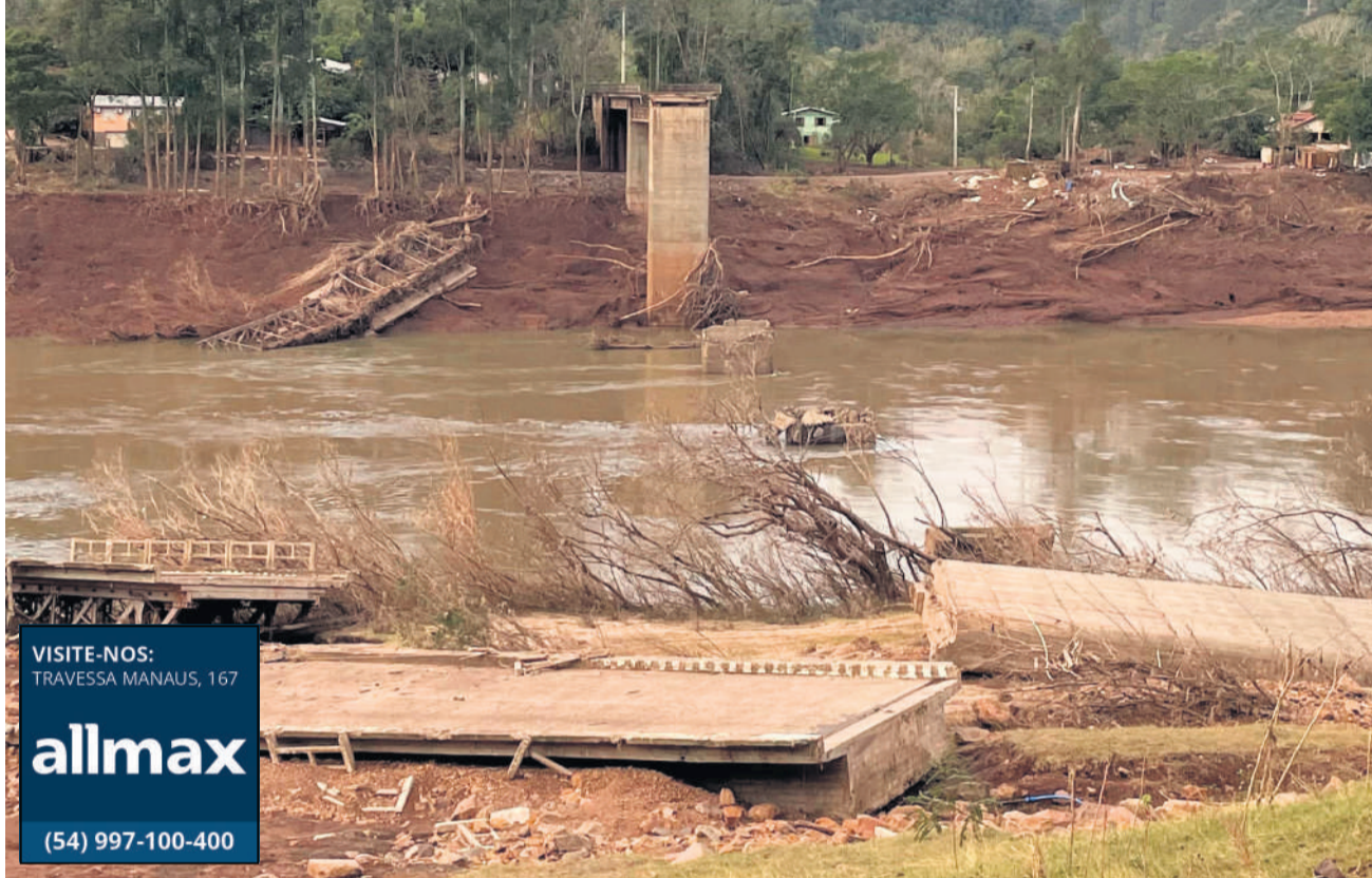
A construção da nova ponte, no valor de R$ 31 milhões, segue longe no horizonte; a balsa, levada pelo Rio Taquari em maio, pode retornar entre 30 e 60 dias, mas menor
